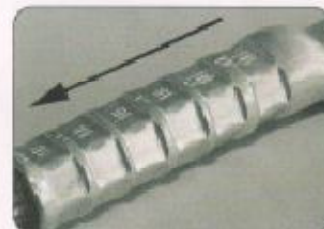
Slika 10: Počnite gnječenje od kraja papučice i nastavite prema provodniku da bi ste osigurali da se kompaktni materijal širi u ovom pravcu.
